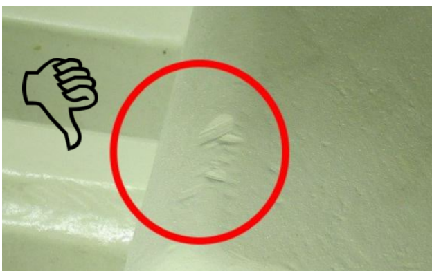
Abbildung 17 Schleifspuren
